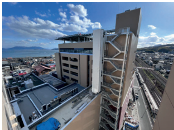
2024年2月時点 完成間近の新病棟
