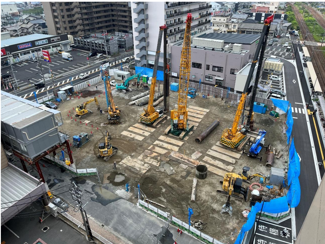
2022年5月31日時点 既存杭撤去等工事
