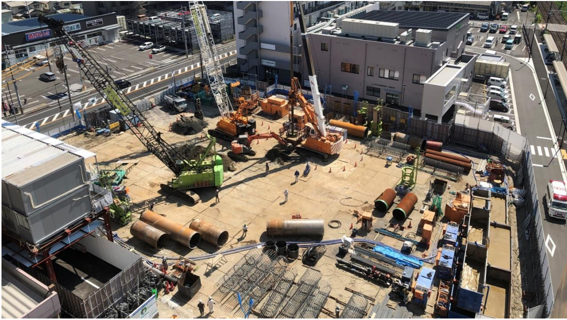
2022年8月30日時点 新設杭工事
