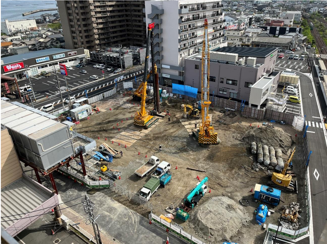
2022年4月25日時点 既存杭撤去等工事
