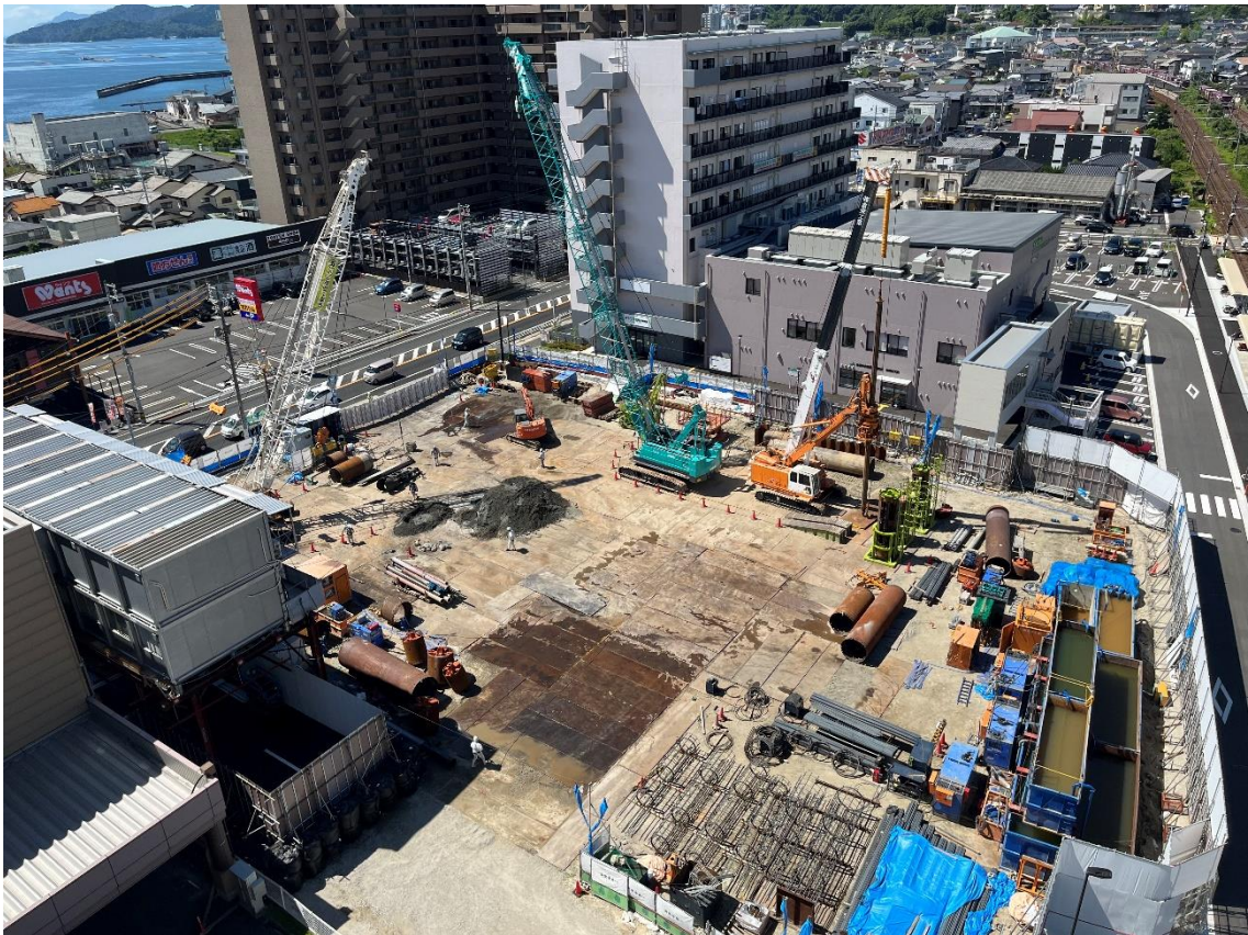
2022年7月29日時点 新設杭工事
