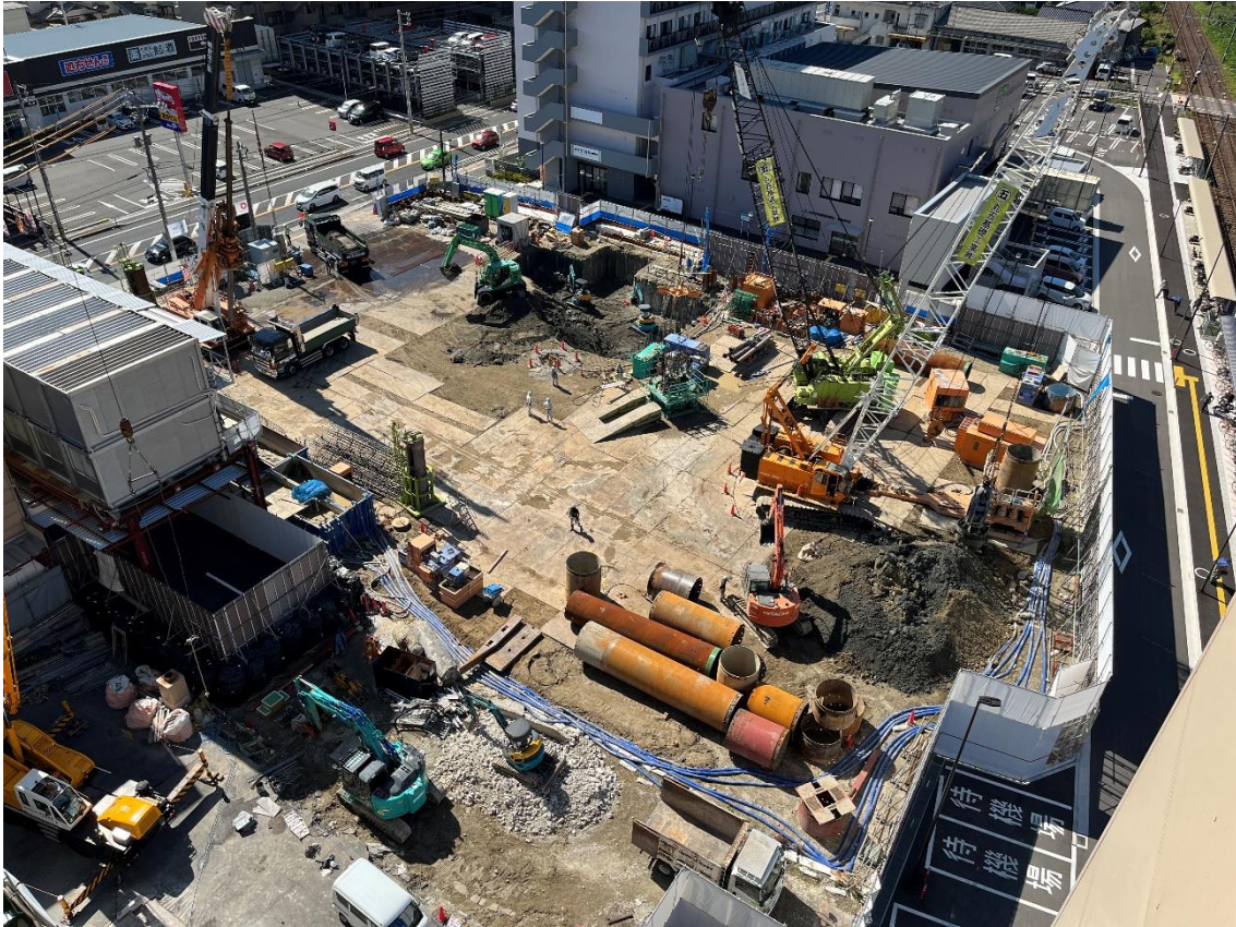
2022年9月30日時点 新設杭工事（およそ半分の杭施工が終わっています）
