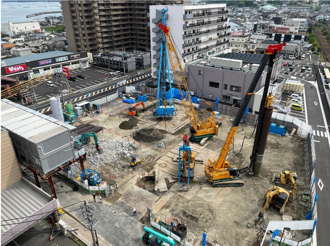
2022年6月20日時点 既存杭撤去等工事
