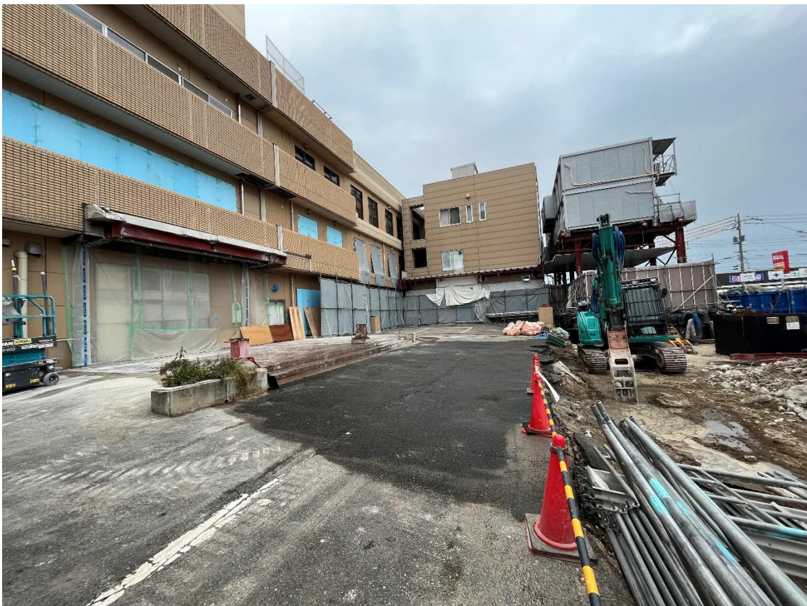
2022年9月26日時点 西棟および地域救命救急センターの出入口の庇（ひさし）が撤去されました。
